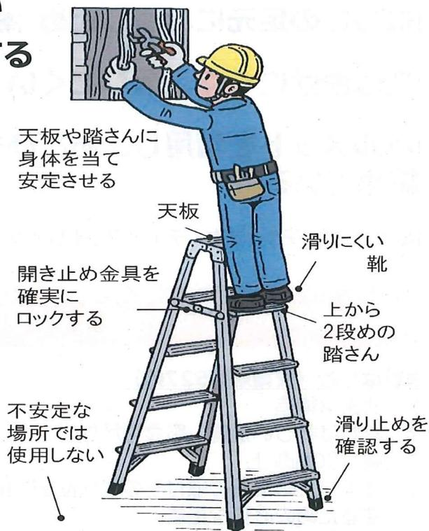
高さ2m以上での作業時は、墜落制止用器具の使用も必要です！
